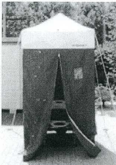
現在のマンホールトイレ上屋（テント式）
